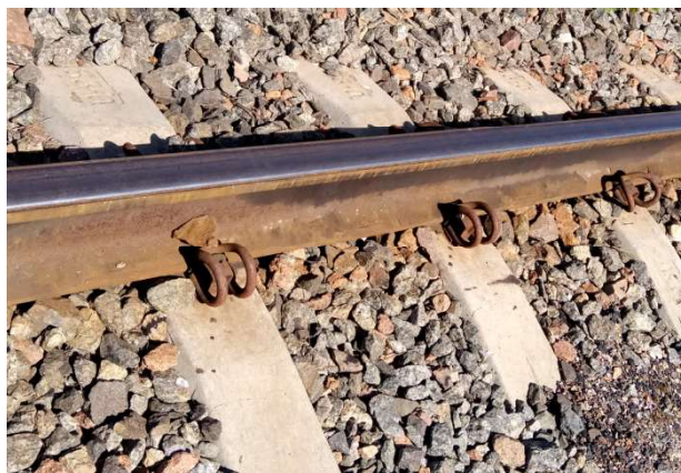
Рис. 1. Фрагмент рельсовой плети на железобетонных шпалах
